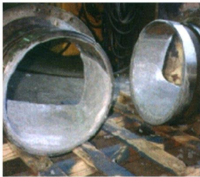
รางป้อนเข้าเครื่องบด ได้รับการซ่อมแซมโดยใช้ WEAR GUARD HIGH LOAD
