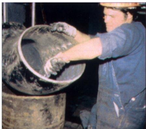
ภายในท่อได้รับการซ่อมแซม และเคลือบด้วย WEAR GUARD HIGH LOAD
