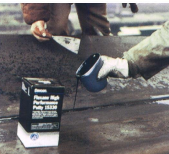
FLEXANE 80 PUTTY ในการซ่อมแซมพื้นผิว
