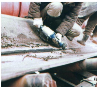
การซ่อมแซมพื้นผิวของสายพานลำเลียง
